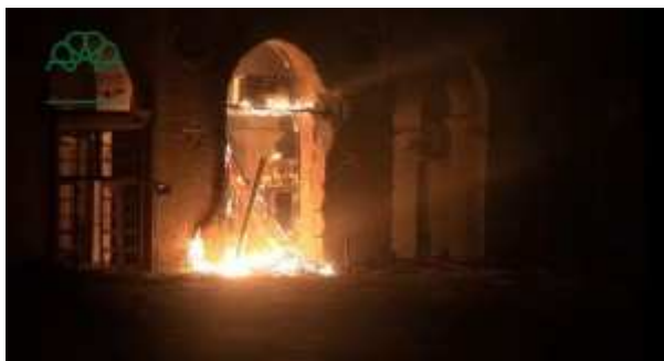
La mosquée omeyyade d'Alep en feu pendant les combats du 1er octobre 2014.
